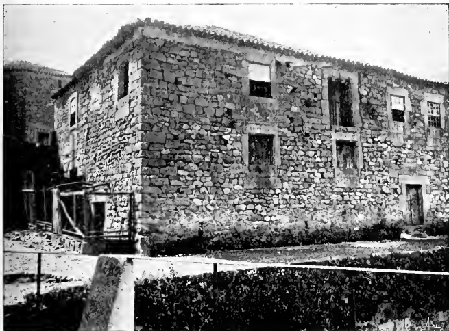
Casa de Marcos Garcia vista de N.-E.
